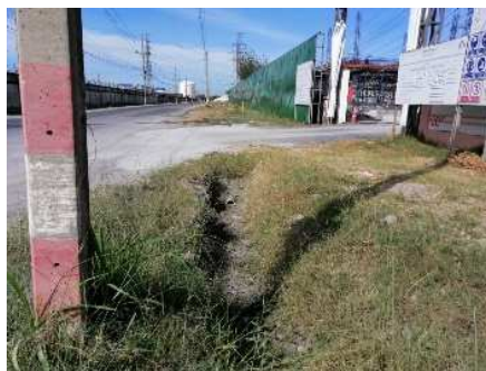
รูปที่ ค-28 จัดทำทางเปียงชั่วคราวหากจำเป็นต้องปิดกั้นทางน้ำ
