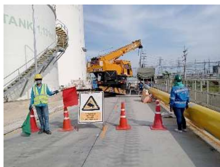
รูปที่ ค-36 การกั้นแบ่งเขตพื้นที่บริเวณที่มีการติดตั้งเครื่องจักร
