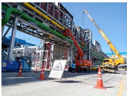
รูปที่ ค-50 กันเขตบริเวณพื้นที่ที่มีการเชื่อมต่อ พร้อมทั้งติดเครื่องหมายเตือนแสดงเขตที่อาจเกิดอันตราย
