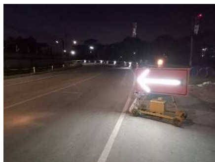
รูปที่ ค-22 กรณีทำงานกลางคืน ต้องติดตั้งไฟสัญญาณกระพริบให้เห็นได้อย่างชัดเจน
