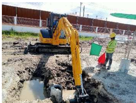
รูปที่ ค-47 กำหนดผู้ทำหน้าที่ขั้บรถขุด และขุดอย่างระมัดระวังไม่ให้ถูกสิ่งที่อยู่ในแนวขุด
