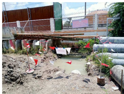
รูปที่ ค-30 โครงการอยู่ระหว่างการก่อสร้างบ่อพักน้ำฝนชั่วคราว
